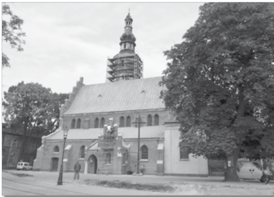
Z okazji 650 rocznicy fundacji radomska fara przechodzi gruntowny remont | Fot. Rafał Natorski
