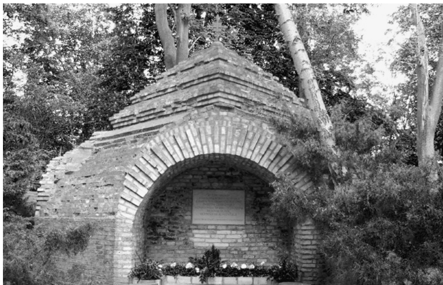
Pozostałości rozpoczętej budowy Świątyni Bożej Opatrzności w warszawskim Ogrodzie Botanicznym
